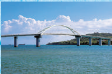
⑰瀬底大橋
